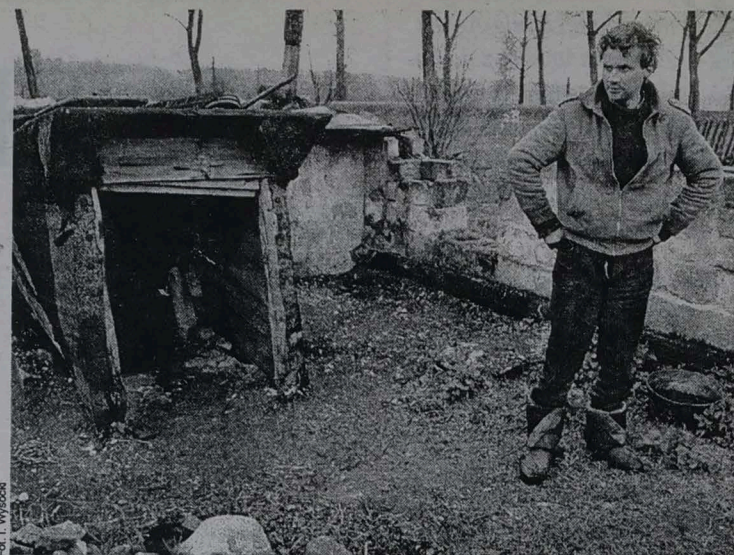
Po pożarze Andrzej postanowił zamieszkać w ziemiance
