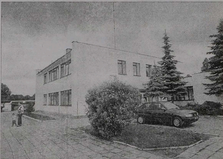
Odremonowany budynek miejskiej przychodni w Mikołajkach
