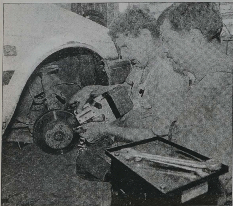
Szlifowanie tarcz hamulcowych urządzeniem Canvik – bez ich demontażu
