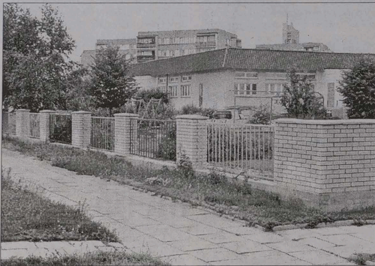
Wyremontowany płot przy Przedszkolu nr 76 przy ul. Różanej 19
