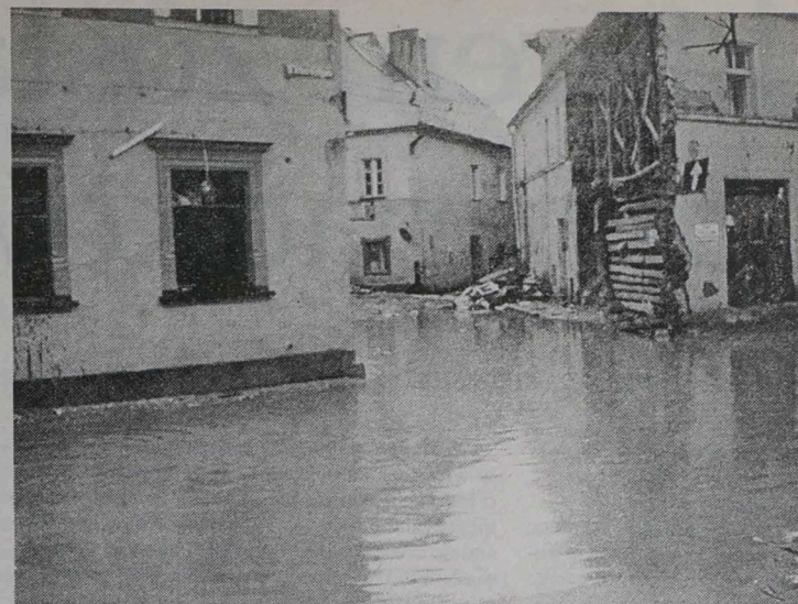
Pozostałości wody powodziowej w kilkanaście dni po wylaniu rzeki
