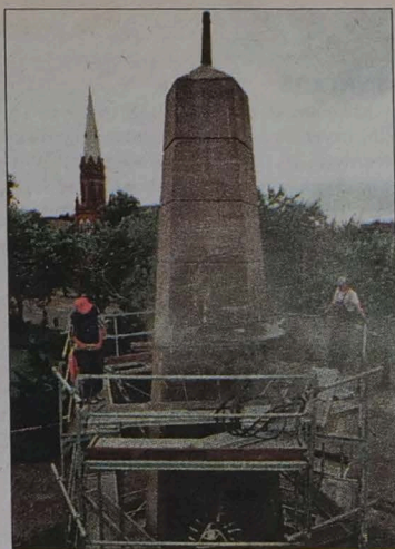
W Toruniu przystąpiono do właściwej rozbiórki pomnika wdzięczności Armii Radzieckiej. Polega ona na pocięciu obelisku specjalnymi diamentowymi piłami na kilkunastotonowe elementy i ich demontażu za pomocą dźwigu. Warto przypomnieć, że dotychczas próbowano go rozbić, przewrócić, rozkuć, a nawet myślano o wysadzeniu go w powietrze. Ostatecznie tego zadania podjęła się jedna z toruńskich firm.
