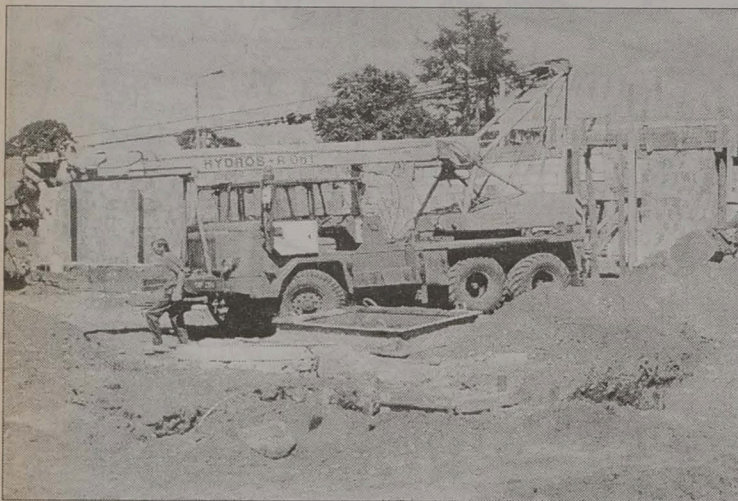
Budowa nowej stacji paliw Statoil w Suwałkach
