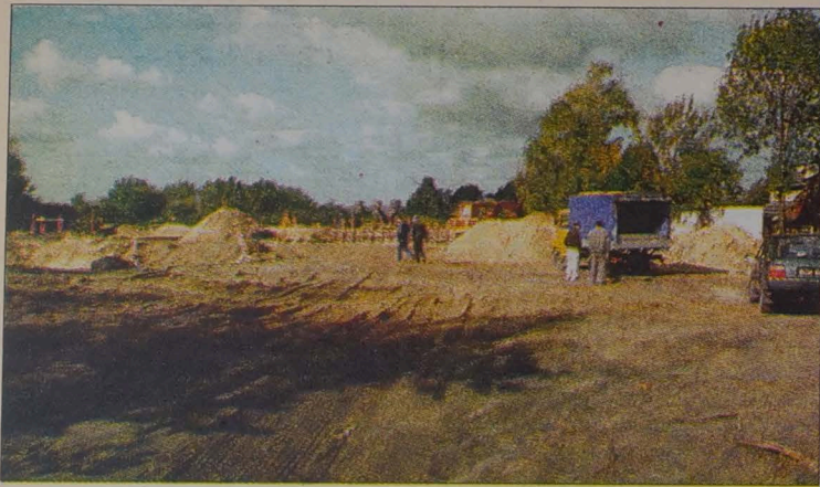
Niewykluczone, że stacja przy ul. Kopernika będzie gotowa jeszcze w tym roku. Obecnie prowadzone są tu prace ziemne.
