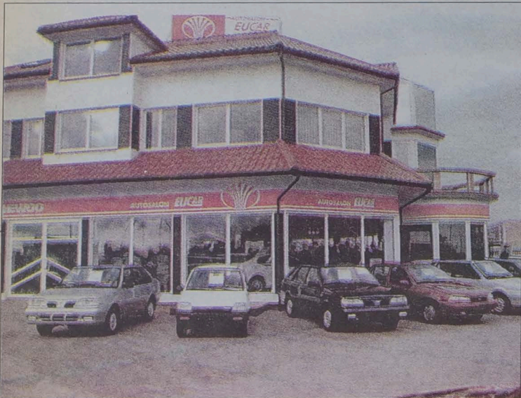
Nowo wybudowany obiekt firmy EUCAR, suwalskiego dealera Centrum Daewoo jest ciekawy architektonicznie i bardzo obszerny – z sensownie zagospodarowanym wnętrzem
