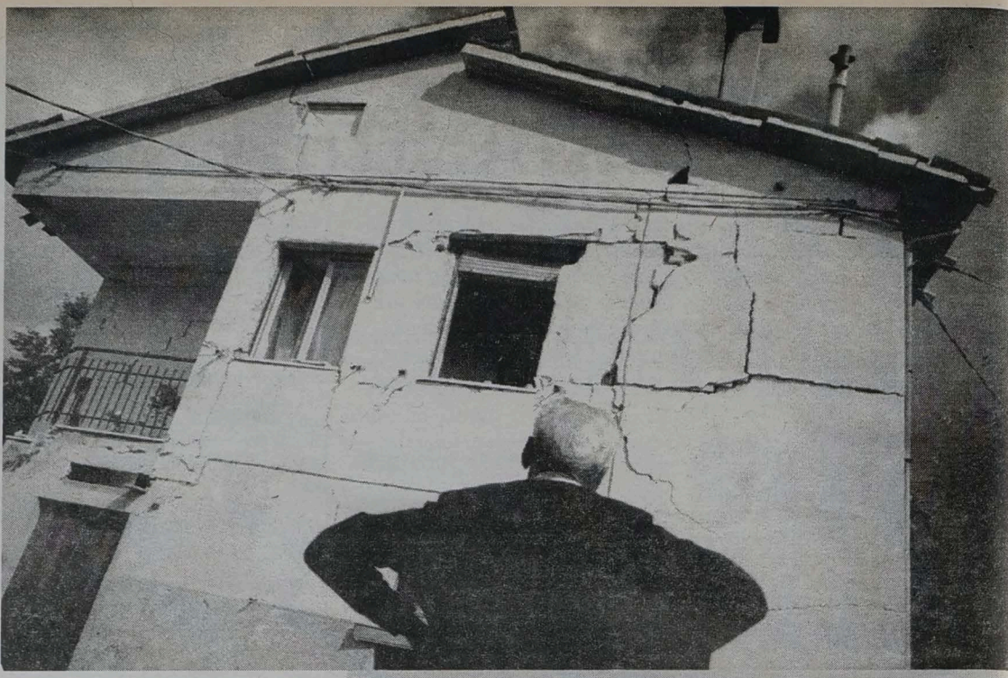
Mieszkaniec małej, górskiej miejscowości Cesi, 80 km od Asyżu, patrzy na swój dom uszkodzony wskutek trzęsienia ziemi w środkowych Włoszech. W rejonach dotkniętych skutkami ruchów tektonicznych trwających od 26 września, 40 tys. osób, których domy zostały zniszczone lub uszkodzone, żyje w namiotach lub przyczepach kempingowych.
