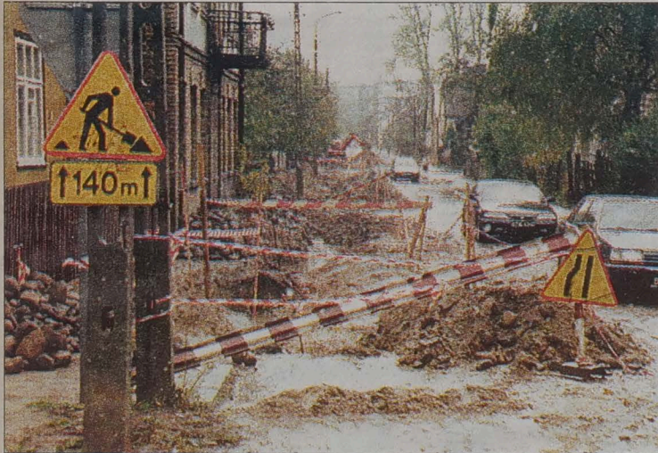
Wykopy na ul. Czystej. Wkrótce z sieci centralnej popłynie tędy ciepła woda.
