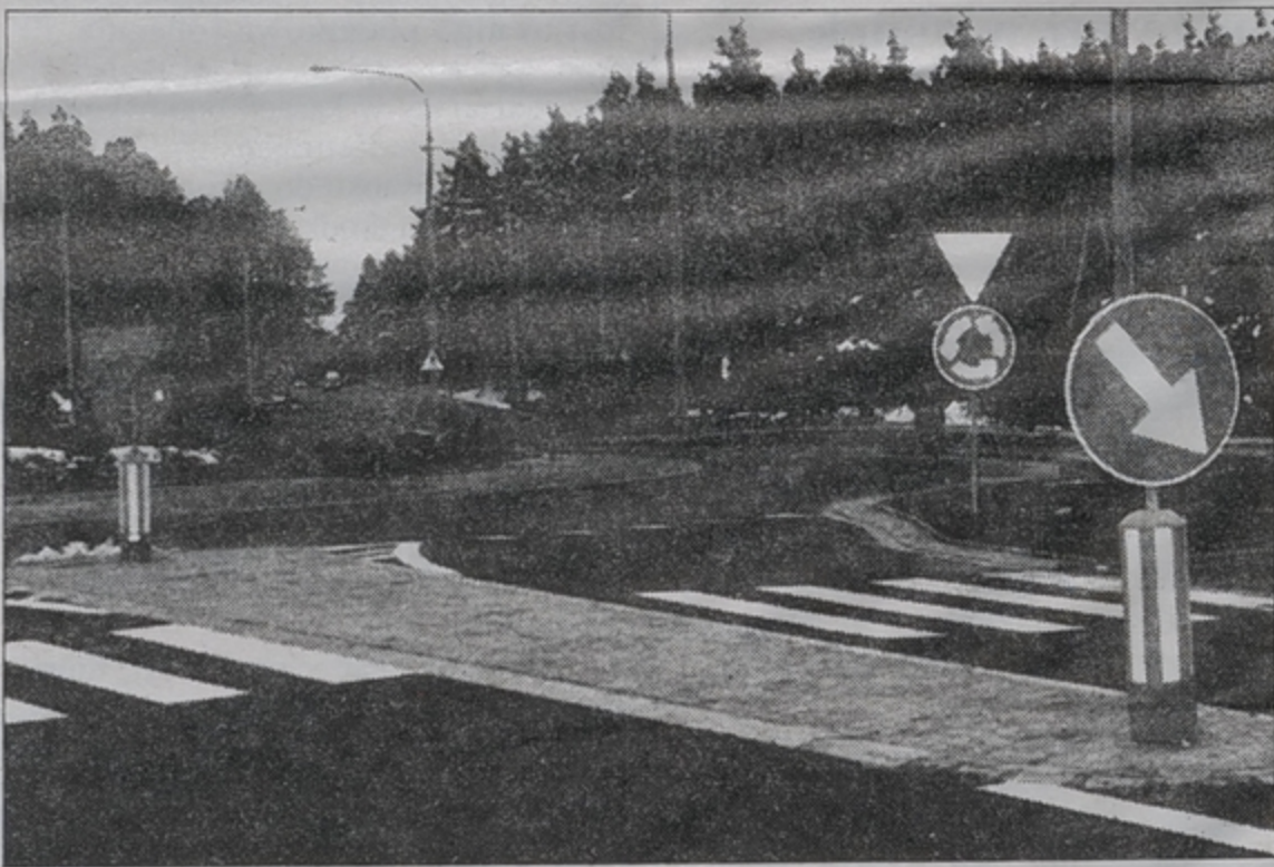
Z dwudniowym poślizgiem drogowcy oddali do użytku rondo na szosie wylotowej do Augustowa, stanowiącej niewłaściwą część suwalskiej obwodnicy. Nareszcie „odetchnie” zabytkowa ulica Kościuszki, przez którą od paru lat dniem i nocą ciągnęły w stronę granicy sznury TIR-ów. (gram) Fot.B. Pieklik
