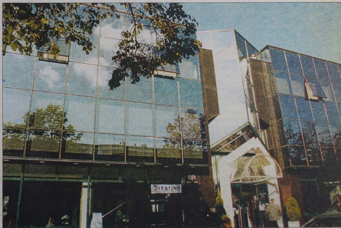
Elewację Banku Gdańskiego w Białymstoku zaprojektował arch. Andrzej Andrzejewski z pracowni proj. „HADA” z Gdańska.
