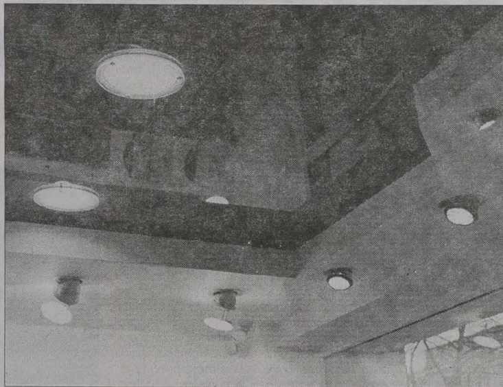
Sufit napinany, zamontowany w jednej z białostockich restauracji daje efekt lustrzanego odbicia. Na tego typu powierzchni można bez problemów zamontować estetyczne oświetlenie.
