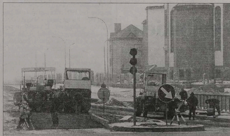
Skrzyżowanie nowo budowanej ul. Sybiraków z ul. Piastowską
