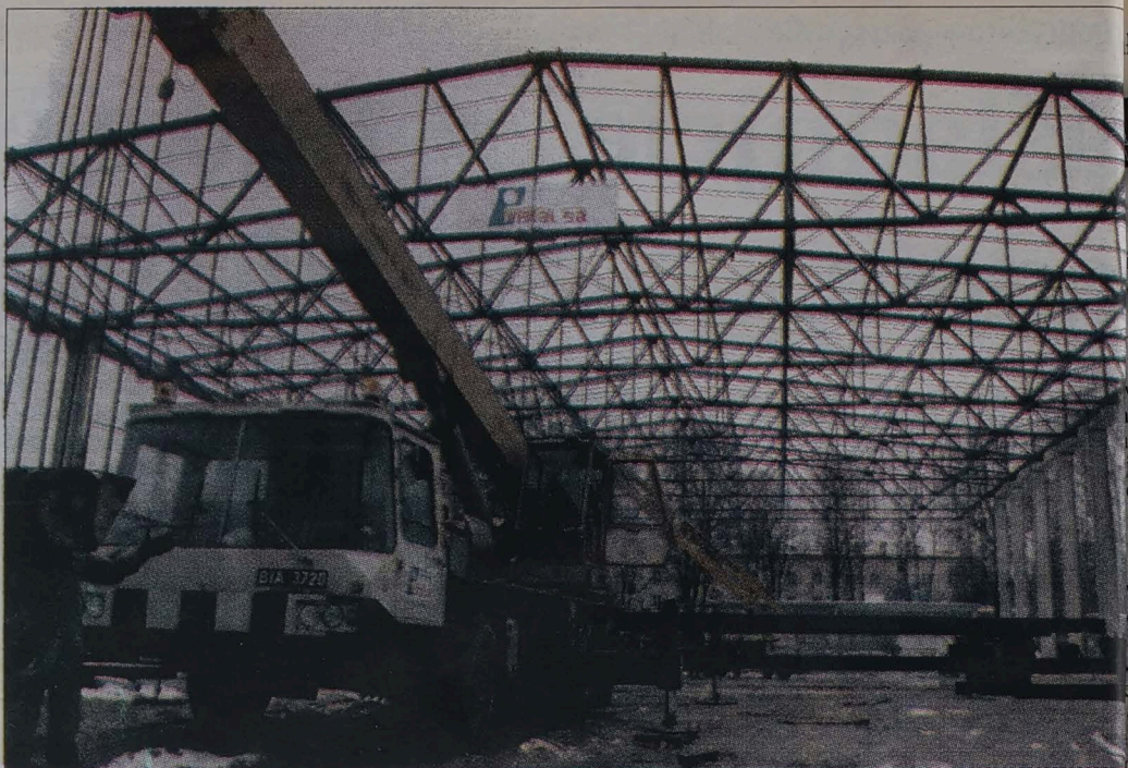
Konstrukcja żelbetonowa już stoi, teraz wszyscy czekają na bandy z Finlandii
