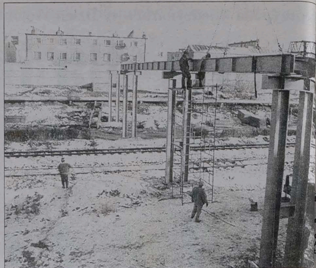
Budowa kładki nad torami w Grajewie
