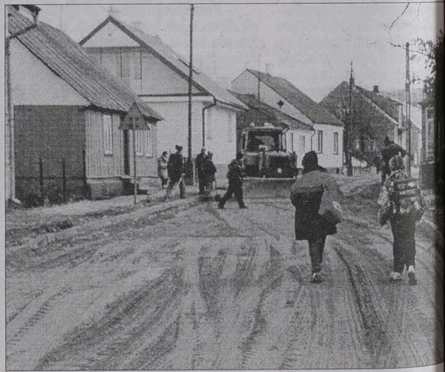
Ulica Szkolna w Rajgrórze wiedzie do jeziora i plaży – centrum turystyki. Od dwóch lat trwają tu prace związane z kanalizacją i wodociągami. Jest szczytny, lecz pilne jest też jak najszybsze przywrócenie drogi do jeździ. Bardziej że codziennie przechodzi nią do Szkoły Podstawowej mnóstwo ludzi. Leży cieszyć się, że nie zdarzył się do tej pory żaden wypadek.
