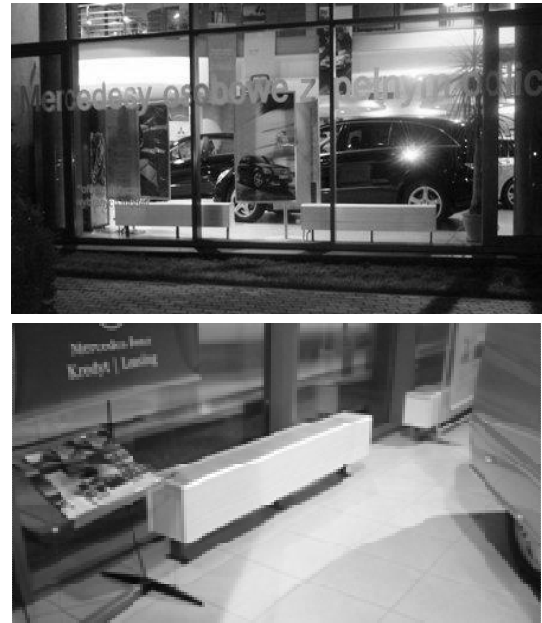
Rys. 3. Przykłady ogrzewania z konwektorami w salonie Mercedes-Benz przy ul. Kleeberga w Białymstoku
