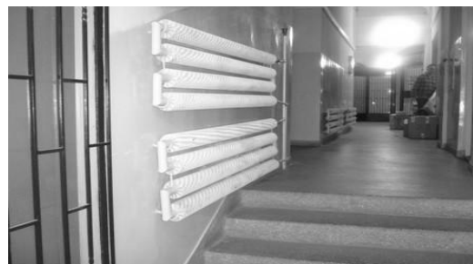
Rys.1. Przykłady ogrzewania lokali użytkowych: a) grzejnik żeliwny członowy w salonie fryzjerskim przy ulicy Stromej w Białymstoku; b) grzejnik rurowy typu „Favier” w pawilonie handlowym przy ulicy Upalnej w Białymstoku
