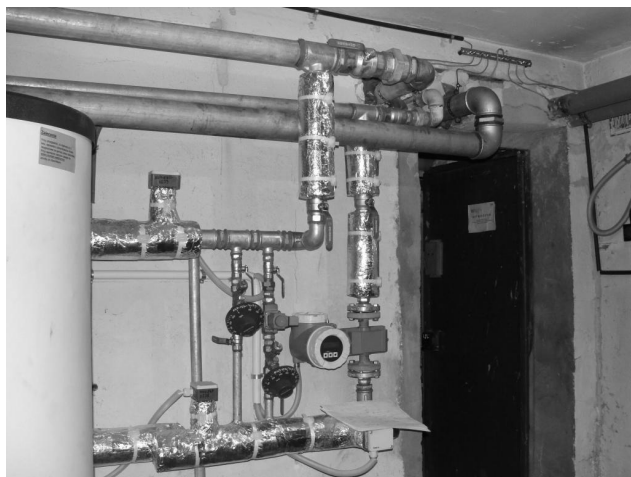
Rys. 2. Układ stabilizacji temperatury i programowego sterowania cyrkulacją
