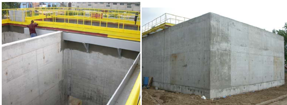
Rys. 3. Żelbetowy zbiornik otwarty usytuowany nad powierzchnią terenu
