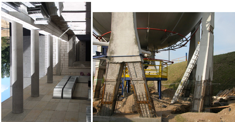
Rys. 1. Przykłady monolitycznych konstrukcji inżynierskich badanych metodami porównawczymi
