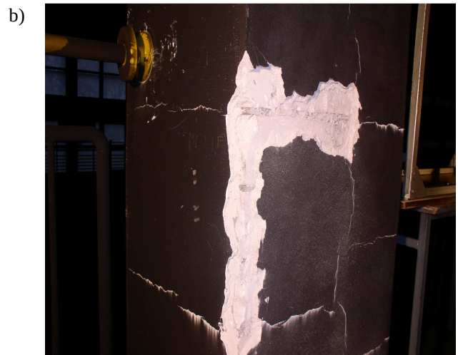
Rys. 5. Efekt działania temperatury pożaru: a) na powierzchni stalowej, b) na elementach murowanych
