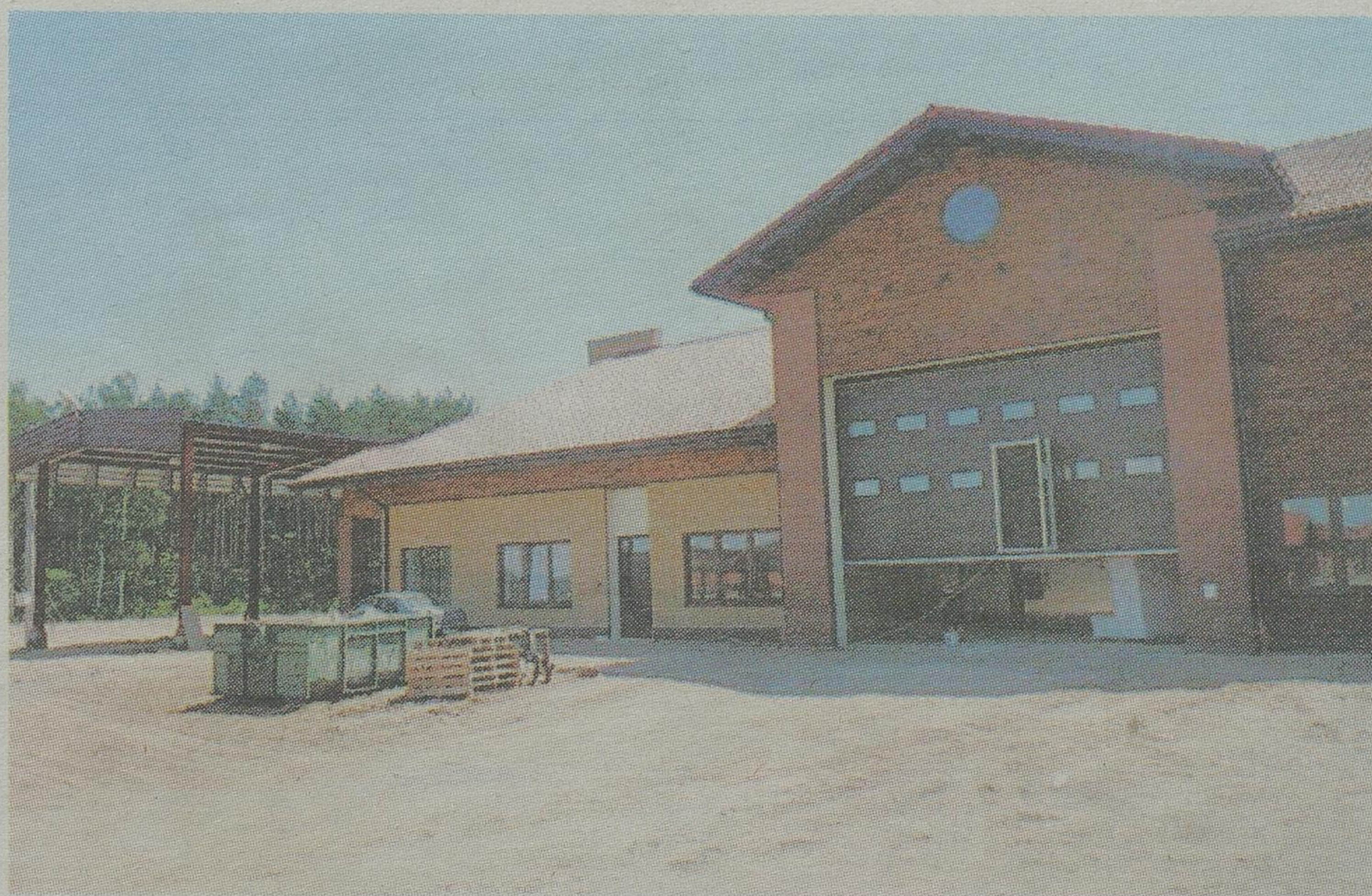
Gotowe budynki na przejściu granicznym w Połowcach czekają na wyposażenie. Podlaski Urząd Wojewódzki ma już pieniądze na ten cel.
