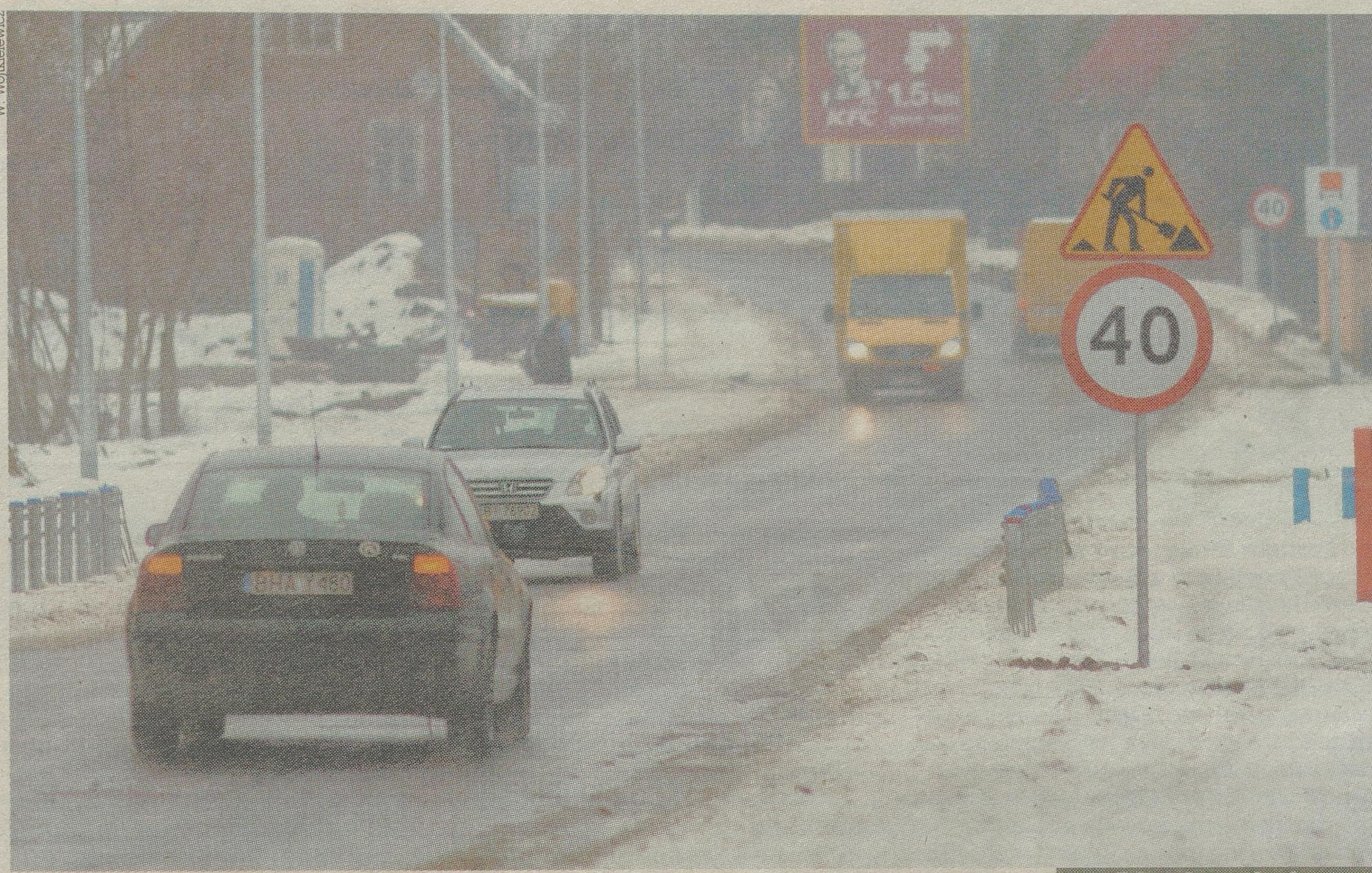
Na razie na Dojlidach Fabrycznych obowiązuje tymczasowa organizacja ruchu. Kiedy linie oddzielające pasy ruchu zostaną już namalowane, kierowcy będą mogli jechać 50 kilometrów na godzinę.
