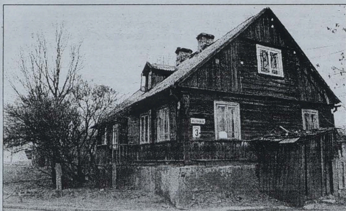
Wiosną rozpocznie się rozbiórka budynku przy ul. Piasta 3
