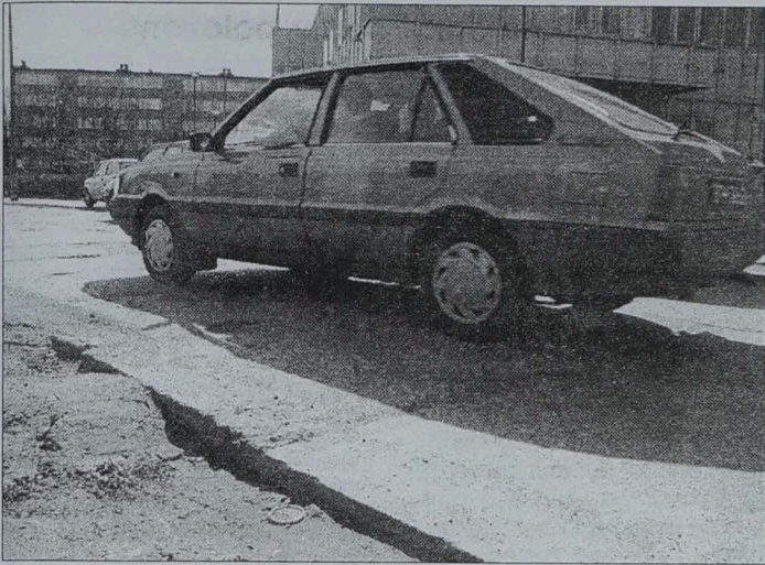
Zamiast dziurawych, betonowych płyt na 150-metrowym odcinku ul. Chrobrego pojawi się asfalt
