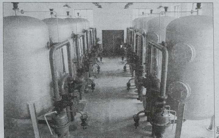
Wymiana żwiru w odzłaziaczach była przyczyną okresowego chlorowania wody z ujęcia na Rybakach.
