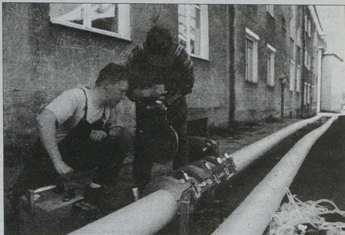
Gazociąg buduje firma Gazomontaż z Wołomina. Prace na ul. Wilsona.
