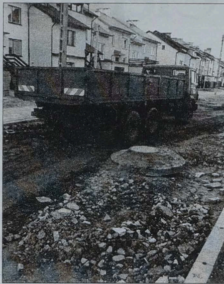
W czerwcu ul. Niemeńska ma zyskać asfaltową nawierzchnię
