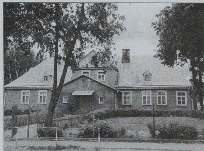
W Rudzie gmina Grajewo wykupiła 4,5 ha terenu. Przeznaczony on zostanie na cele publiczne. Na wykupionym obszarze, przy wjeździe do Rudy (od strony Grajewa) po lewej stronie, prawdopodobnie powstanie szkoła. Obecna placówka oświatowa (na zdjęciu) wymaga remontu. Uczą się w niej dzieci nie tylko z Rudy, ale i z ościennych wsi.
