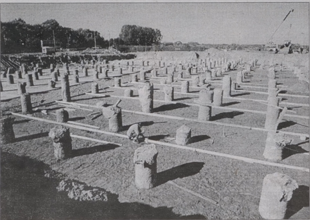
Pale już zabito... modernizacja oczyszczalni w Łomży
