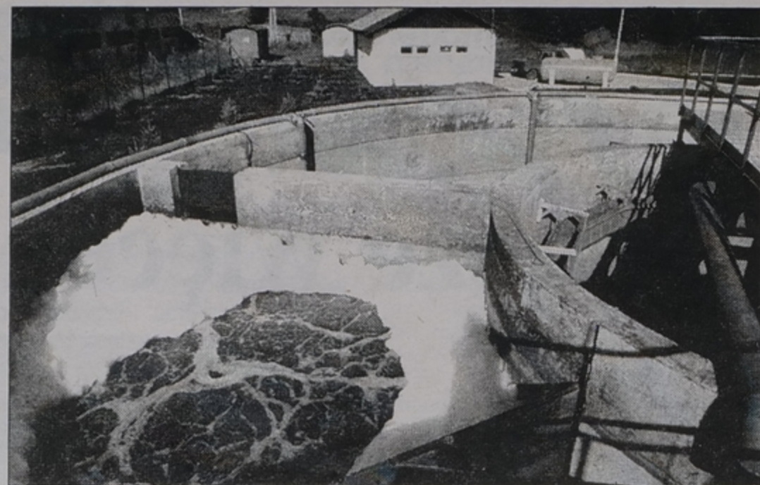
Trwa rozruch gminnej oczyszczalni ścieków w Starych Juchach
