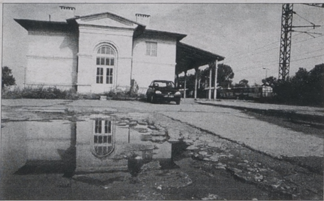
Dojazd do dworca kolejowego w Grajewie od lat jest w fatalnym stanie. Mnóstwo głębokich dziur w starym asfalcie to widok witający przyjezdnych. Czy rzeczywiście tak musi wyglądać otoczenie dworca – wizytówki miasta? (an)
