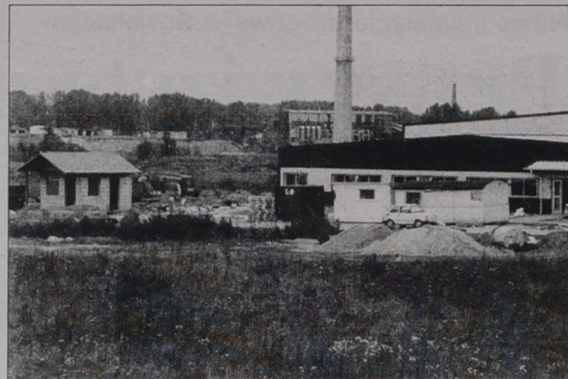
Prace przygotowujące infrastrukturę nowej dzielnicy przemysłowej rozpoczęły się jesienią 1997 r.
