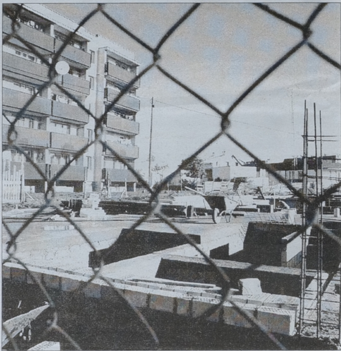
Budowa została już rozpoczęta, tymczasem inwestor musi ubiegać się o... pozwolenie na budowę
