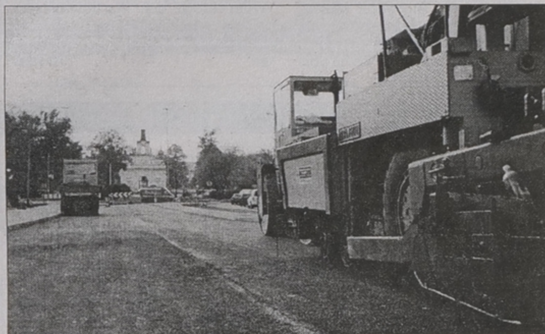
Pod koniec tygodnia na połowie ul. Pałacowej będą już ułożone wszystkie warstwy asfaltu. Na razie drogowcy ułożyli dwie z nich.
