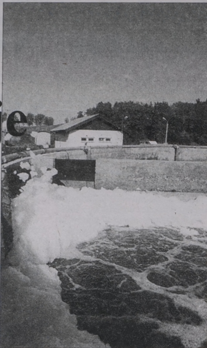
Największym przedsięwzięciem była biologiczno-mechaniczna oczyszczalnia ścieków, która obecnie jest w fazie rozruchu
