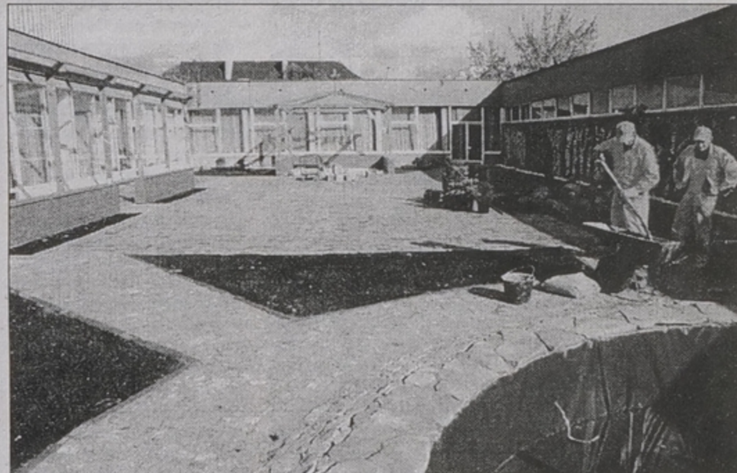
Na dziedzińcu Filharmonii kończą się prace budowlane. Już wiosną będzie tu można w miłych warunkach posłuchać muzyki klasycznej.
