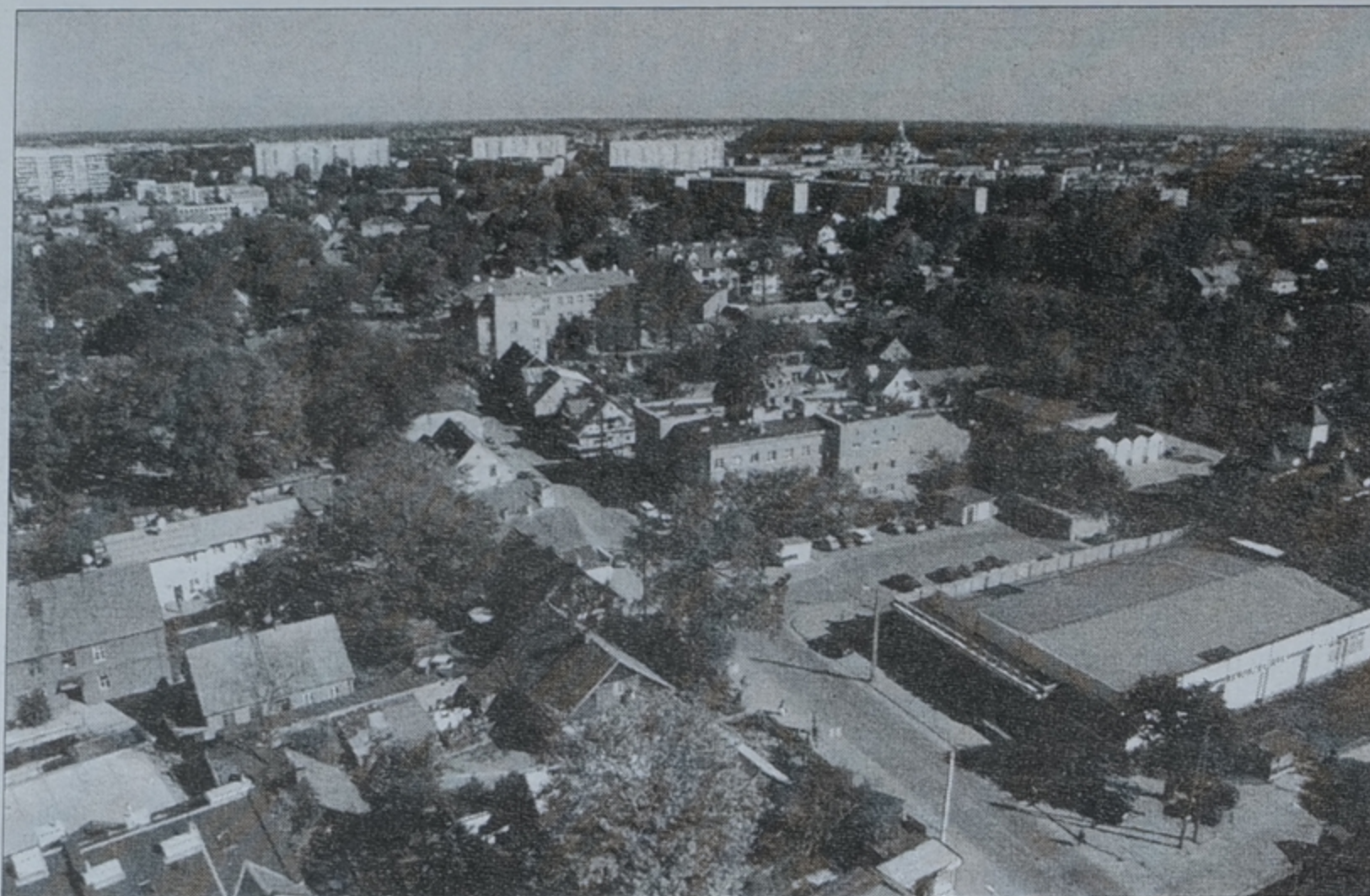
W przyszłym roku remontowana będzie także ul. Słonimska
