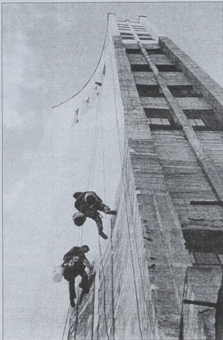
Prace na wieży kościoła św. Jadwigi w Białymstoku
