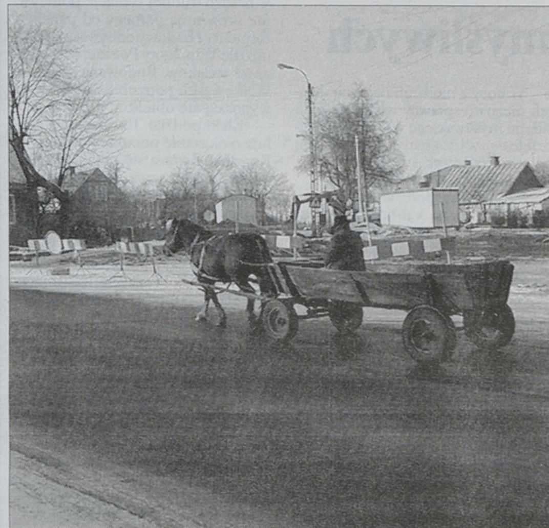
Mróz unieruchomił prace przy budowie kolejnego suwalskiego ronda, u zbiegu ulic Bakalarzewskiej i 23 Października. Nowe rondo usprawni ruch pojazdów w stronę Olecka i dalej do Giżycka i Olsztyna oraz w kierunku Gołdapi. Rondo będzie miało takie same parametry, jak dwa inne – przy ul. Reja i Wojska Polskiego. Z powodu małych rozmiarów suwalskie ronda nazywane są bertami. Skutecznie za to zmuszają kierowców do zdejmowania nogi „z gazu”. (m)
