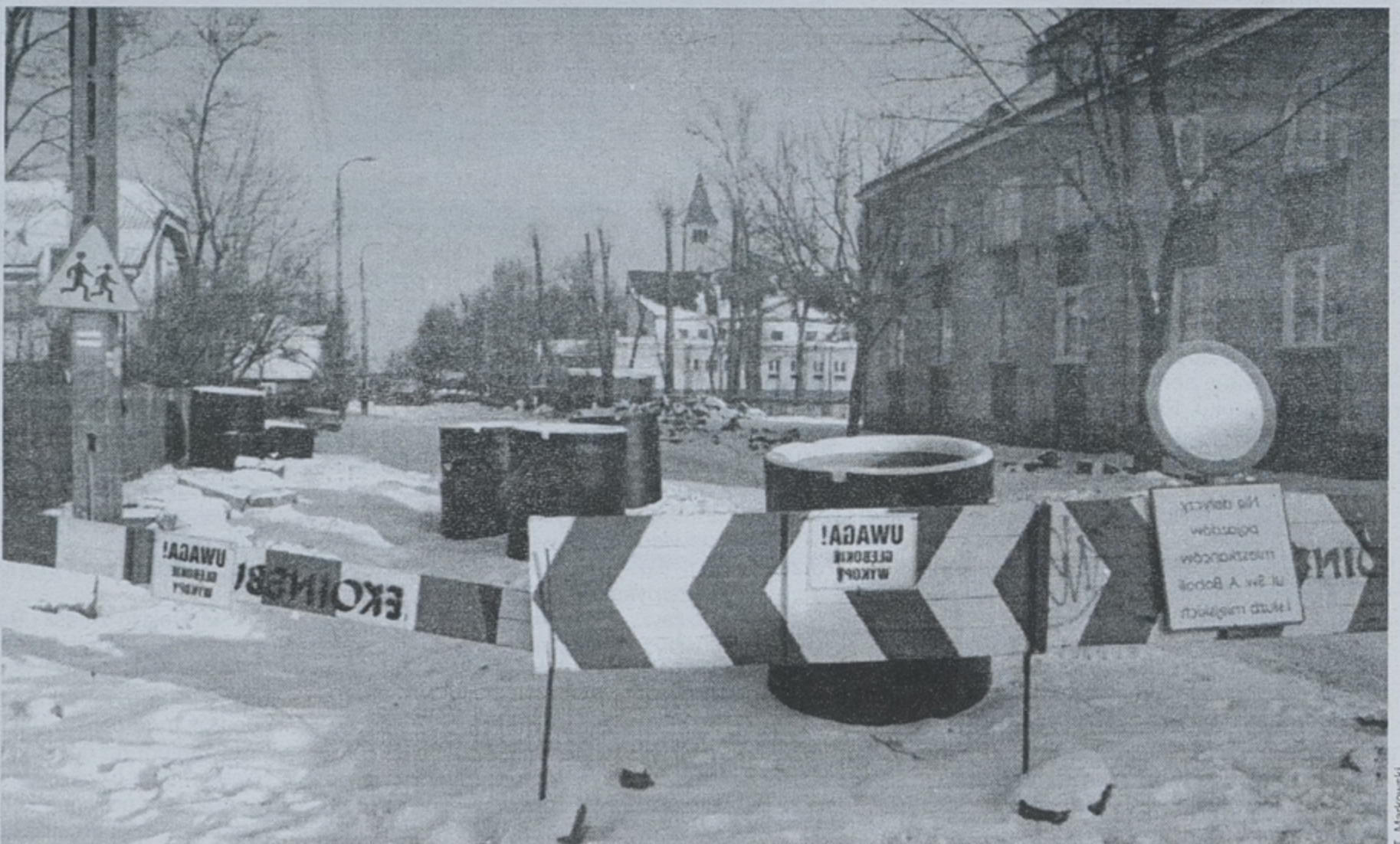
Ulica św. Andrzeja Boboli. Do czerwca mają być zakończone prace na odcinku znajdującym się na osiedlu Starosielce. Później drogowcy rozpoczną budowę na Leśnej Dolinie.
