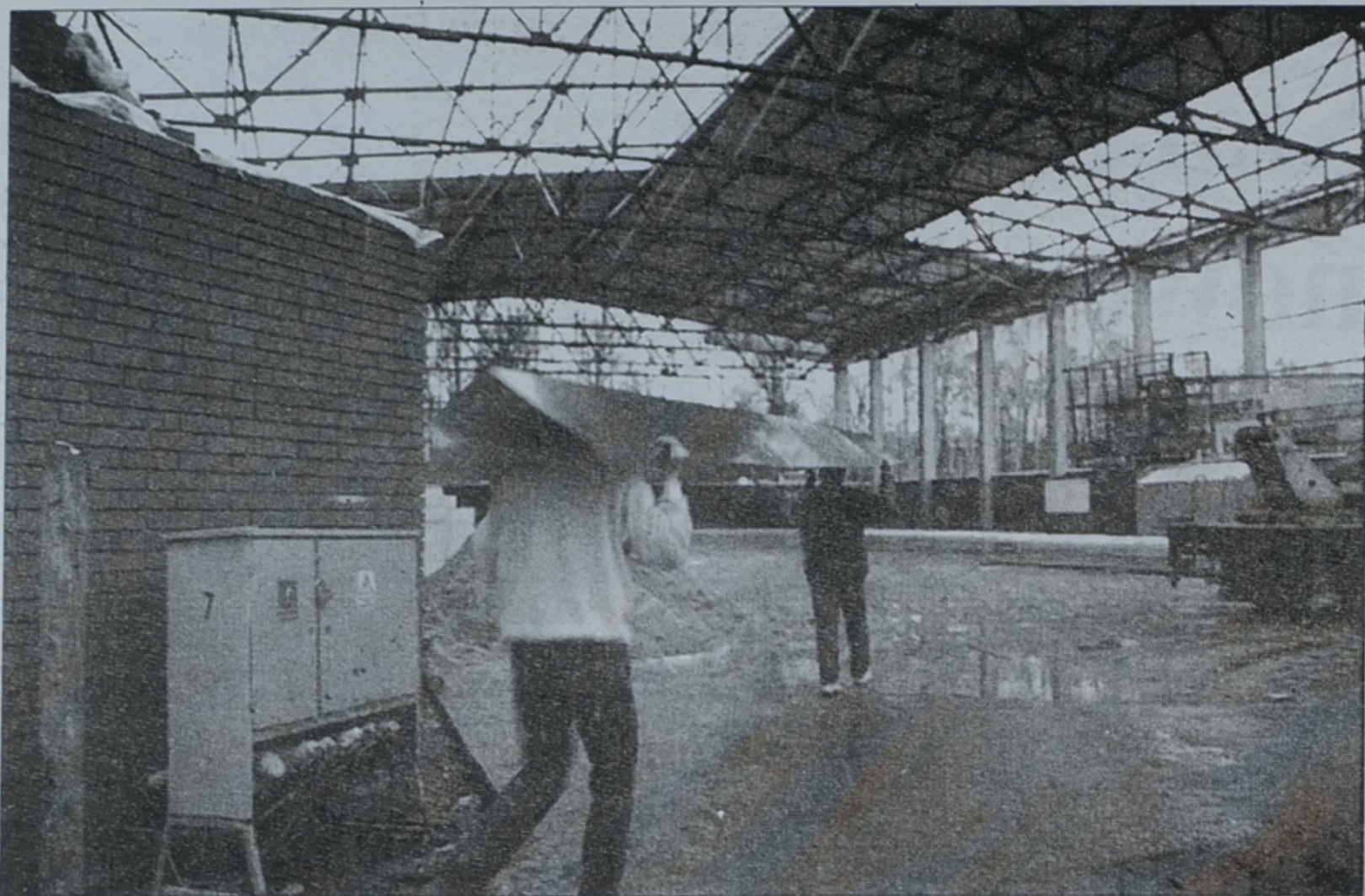
Na lodowisku w Zwierzyńcu trwają ostatnie prace przed rozpoczęciem nowego sezonu łyżwiarskiego
