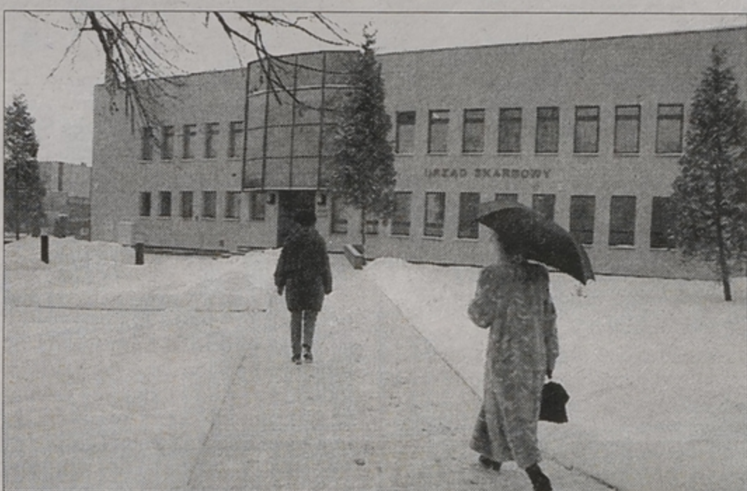
Tak prezentuje się Urząd Skarbowy w Siemiatyczach po generalnym remoncie. US otrzymał obiekt „w spadku” po byłej PZPR. Budynek zbudowano w 1968 r. Od czasu powstania nie był remontowany. Front gmachu ozdobił i urozmaicił przeszklony element, który umieszczono nad wejściem do US. Elewacja i ramy okien mają barwę zielonkawą, podobnie wystrój wnętrza. Remont trwał 6 miesięcy. (u)
