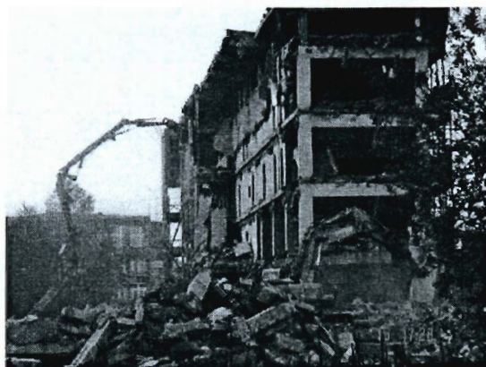
Rys. 4. Wyburzanie budynku metodą mechaniczną, przy użyciu urządzeń dźwigniowych
