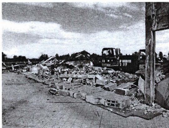
Rys. 6. Gruz rozbiórkowy powstały w wyniku wyburzenia hali (wyodrębniono większe elementy)
