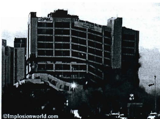
Rys. 7, 8. Wyburzanie obiektów przy użyciu specjalistycznych materiałów wybuchowych (Źródło: www.Implosionworld.com )
