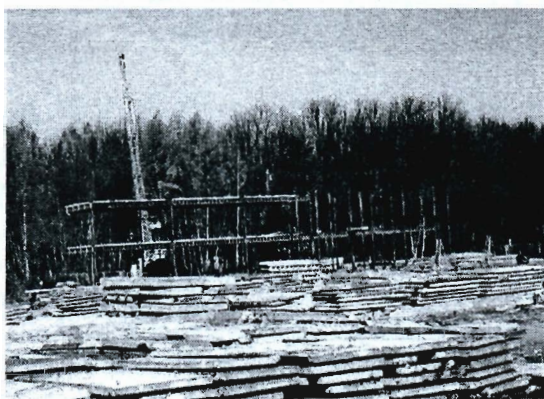
Rys. 5. Płyty prefabrykowane pochodzące z rozbiórki budynku
