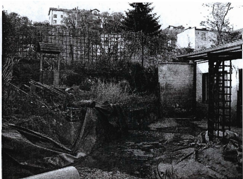
Rys. 2. Wypływ wody na działce nr 72; z prawej strony – budynek gospodarczy
