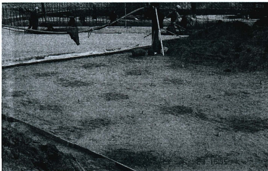
Rys. 3. Widok powierzchni dna wykopu (na pierwszym planie widoczne miejsca zagęszczania i wprowadzania kruszywa w podłoże; w tle: wykonywanie warstwy podbetonu i zbrojenia płyty fundamentowej)- zdjęcie „Invest Komfort” S.A
