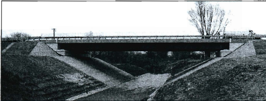
Rys. 2. Widok przebudowanego obiektu
