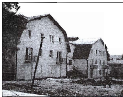
Rys. 9. Obiekty w trakcie realizacji
