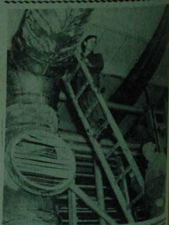
Dobre warunki rozwojowe posiada w naszym województwie przemysł drzewny. W tym roku ruszyła w Suwałkach budowa wytwórni płyt wierowych na adrejs. Zwiększenie produkcji przemysłu drzewnego wzrosło z 1,43 tys. osób w roku 1945 do 3 tys. w roku 1964.
