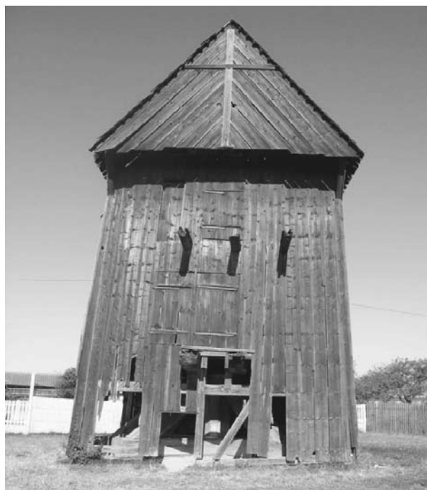
Ryc. 1. Wiatrak w Dębnie przed rozbiórką w 2008 roku. Fot. autorka
