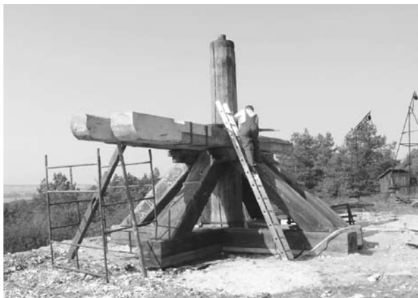
Ryc. 11. Posadawianie koźlaka z Dębna w skansenie w Tokarni. Montaż koźła , pojazdów i sztymbra . Drewno w jasnym kolorze to uzupełnienia i flekowanie zniszczonych fragmentów. Fot. autorka
