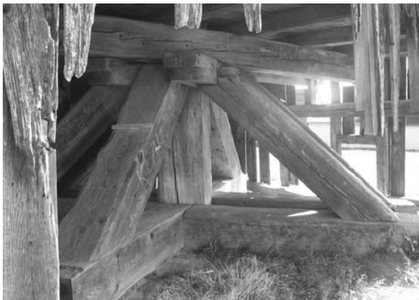
Ryc. 2. Wiatrak z Dębna przed demontażem - widoczna konstrukcja koźła: belki podwaliny, ukośne zastrzały, siodło z 2 pojazdami i sposób mocowania sztymbra w belkach podwaliny. Fot. autorka
