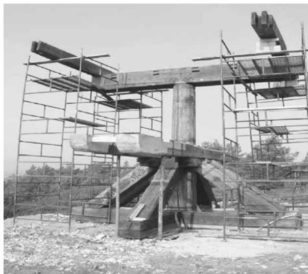
Ryc. 12. Montaż koźlaka z Dębna w skansenie - nakładanie mącznicy na górny koniec sztymbra . Fot. autorka
