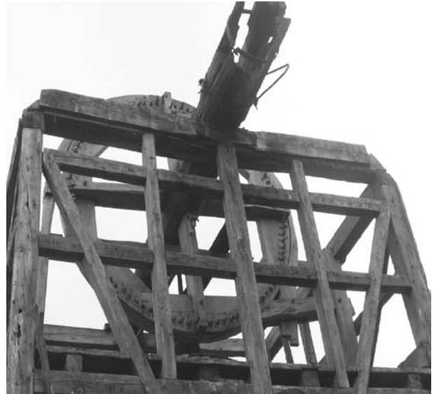
Ryc. 7. Wiatrak z Dębna w trakcie rozbiórki – widoczna konstrukcja ściany, fragment wału skrzydłowego ze zniszczoną głowicą i koło paleczne ze stawidłem. Fot. autorka
