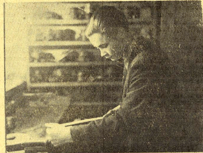
Na zdjęciu: Leonard Sobolewski — uczeń Technikum Budowlanego przy pracy w czasie zajęć praktycznych w Miejskim Przedsiębiorstwie Gospodarki Komunalnej, Wydz. Wodno-Kanalizacyjny w Białymstoku.
