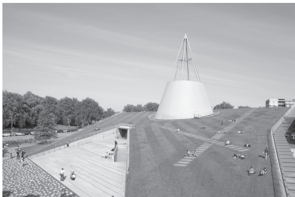
Ryc. 11. Fasada-dach TU Delft Library. Źródło: dzięki uprzejmości TU Delft Library.
