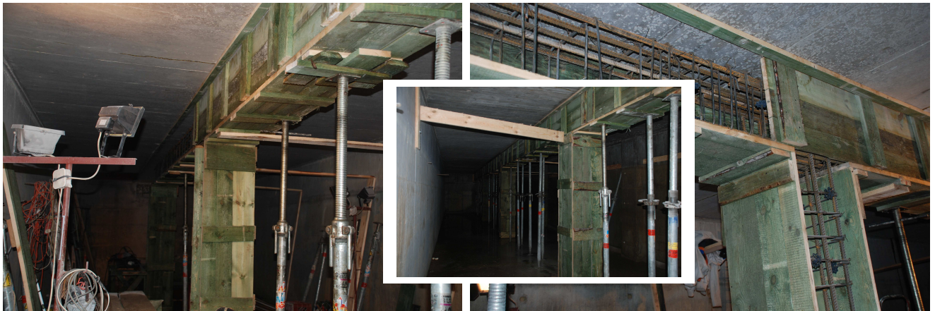
Rys. 10. Realizacja wewnętrznej konstrukcji wzmacniającej płytę zbiornika
