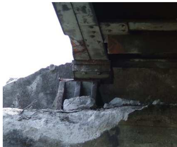
Rys. 1. Uszkodzenia konstrukcji: a) powstałe w wyniku nierównomiernego osiadania (Kwiecień, 2007), b) powstałe w wyniku wykołowania pociągu (Bień, 2009)
