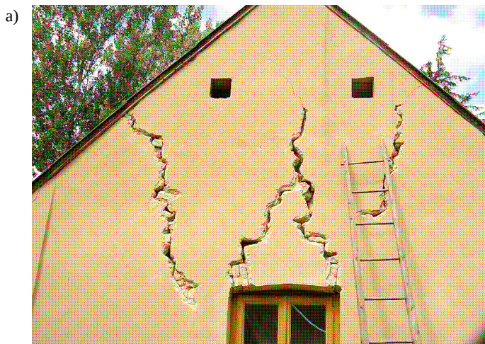
Rys. 1. Uszkodzenia konstrukcji: a) powstałe w wyniku nierównomiernego osiadania (Kwiecień, 2007), b) powstałe w wyniku wykołowania pociągu (Bień, 2009)
