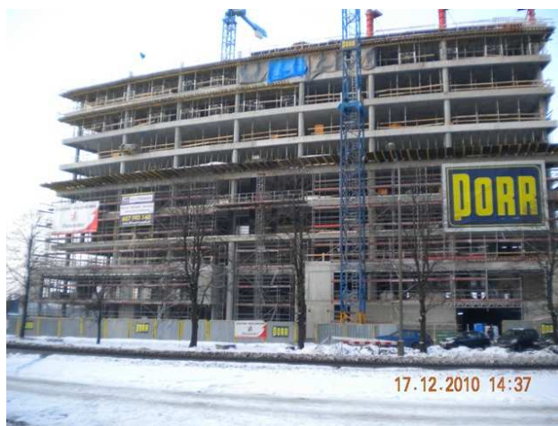
Fot. 14. Budowa Equator II w Warszawie
