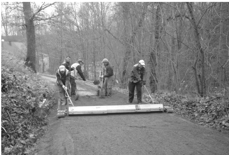
Rys. 2. Profilowanie nawierzchni listwą (fot. własna)
