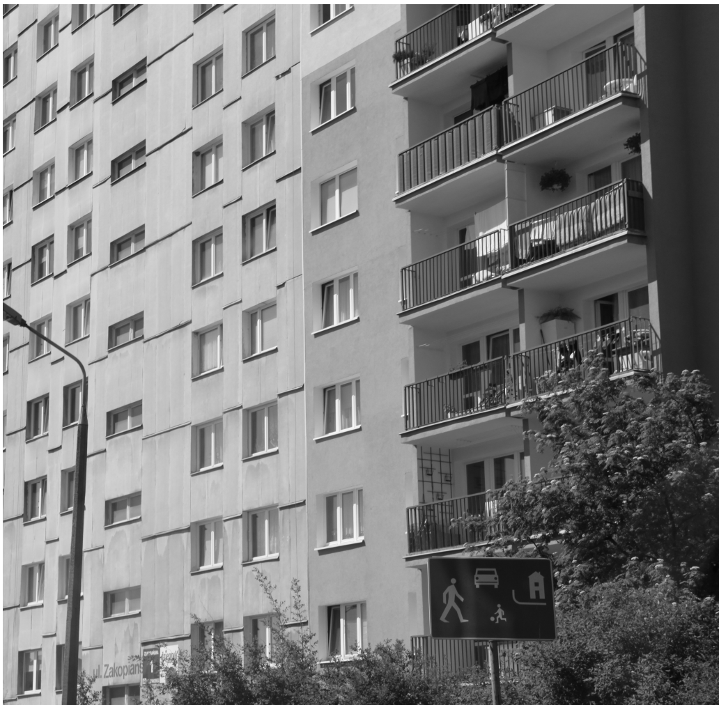
Rys. 3. Widok fragmentu budynku wielkopłytkowego i loggi cofniętych. Stan techniczny zadowalający
