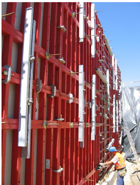
Fot. 8. Szalunek MAMMUT – ściany o wysokości 11 m
