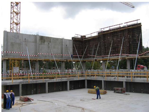
Fot. 20. Szalunek Logo – budowa Aquapark w Suwałkach
