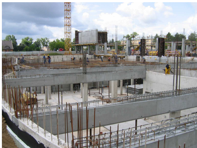
Fot. 19. Budowa Aquaparku w Suwałkach
