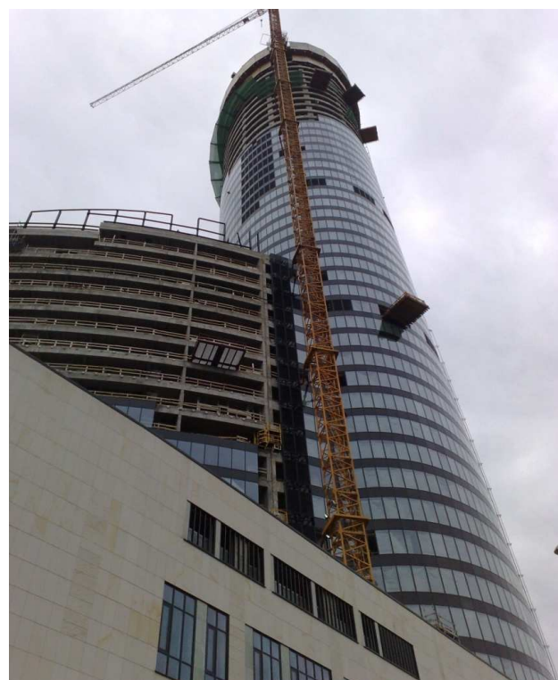
Fot. 3. Pomosty zewnętrzne do transportu pionowego (tak zwane wysuwnice)
