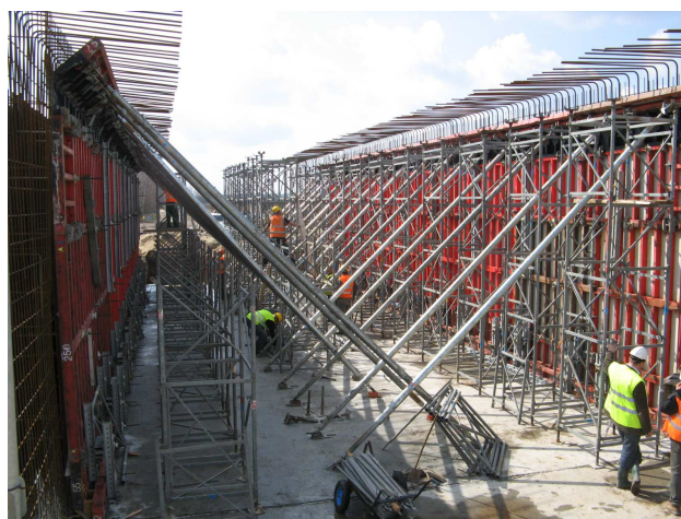
Fot. 6. Szalunek MAMMUT na budowie ścian tunelu
