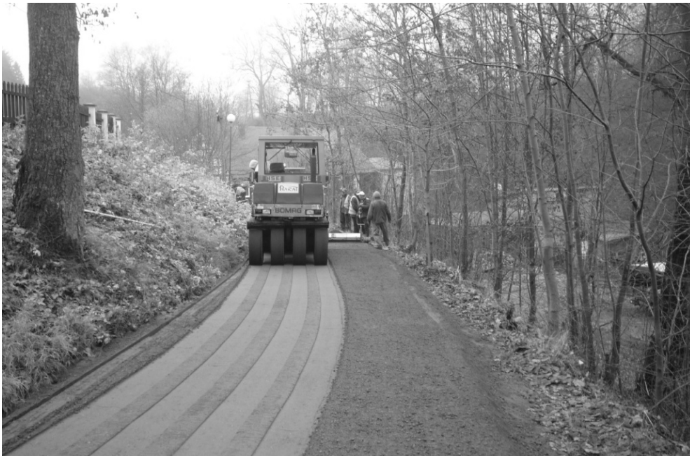
Rys. 3 Zagęszczanie betonu drogowym walcem wibracyjnym (fot. własna)
