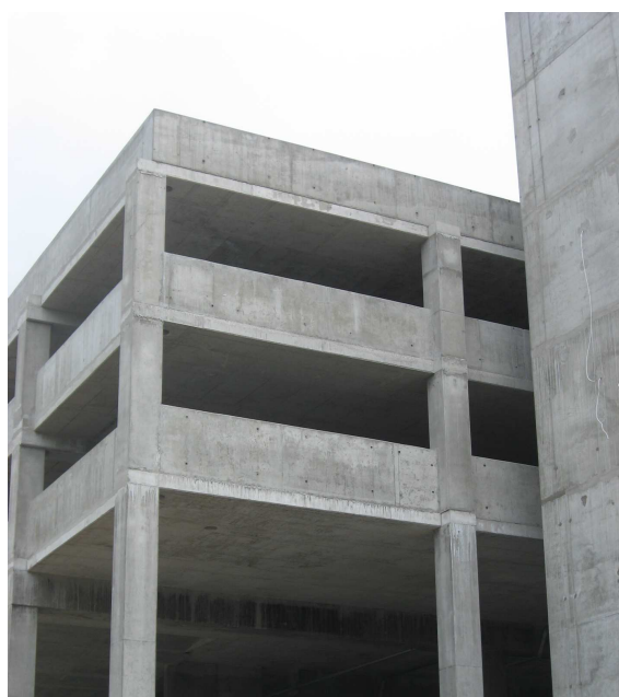
Fot. 10. Wysoka jakość betonu w szalunkach MAMMUT
