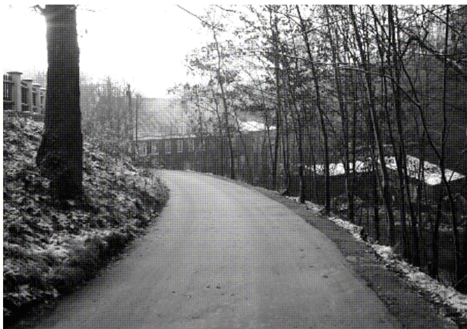
Rys. 4. Nawierzchnia ul. Fabrycznej w Miastku kilka tygodni po zakończeniu robót (fot. własna)
