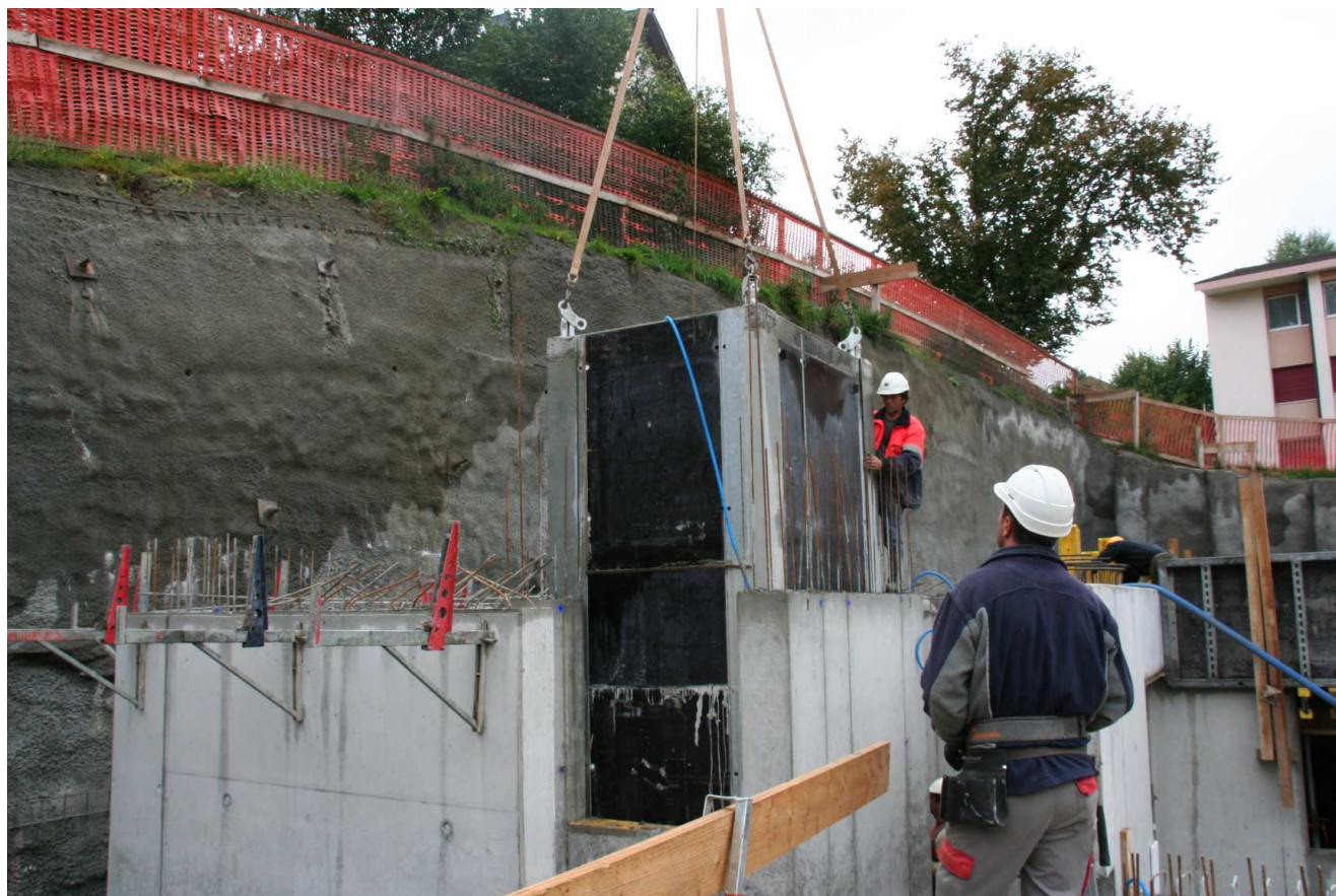
Fot. 5. Demontaż deskowania wewnętrznego
