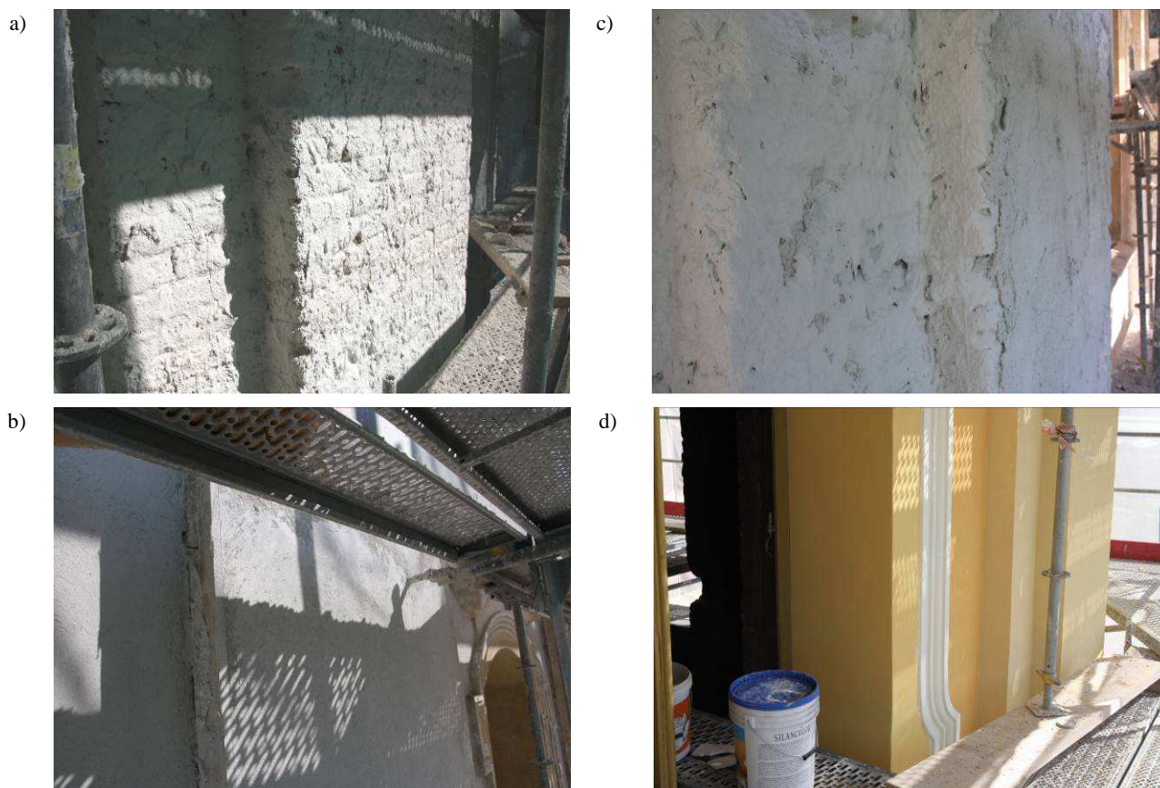
Rys. 2. Układ kolejnych warstw tynku renowacyjnego na Wieży Kościoła oo. Jezuitów w Starej Wsi: a) tynk podkładowy Mape-Antique Rinzafo, b) tynk renowacyjny Mape-Antique MC, c) warstwa wygładzająca Mape-Antique FC, d) hydrofobowy, cienkowarstwowy, barwiony w masie silikonowy tynk nawierzchniowy Silancolor Tonachino – zdjęcia z archiwum MAPEI Polska Sp. z o. o.
