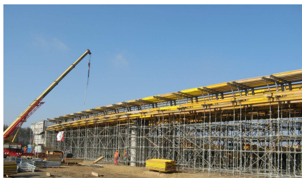
Fot. 7. Podparcie ustroju nośnego – system PAL-BS
