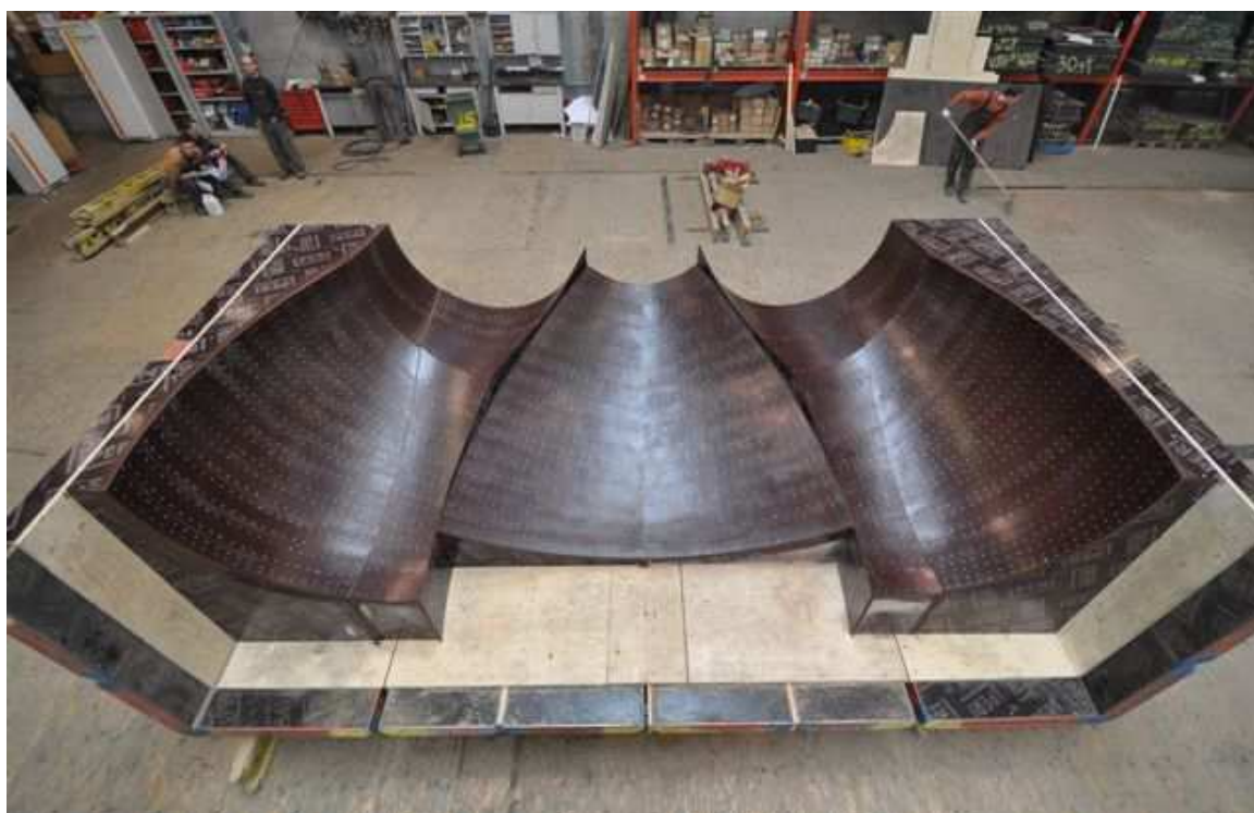
Fot. 4. Deskowania specjalne wykonane w bazie PERI
