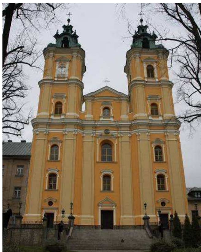
Rys. 3. Wieże Kościoła o. Jezuitów w Starej Wsi po renowacji z wykorzystaniem systemu Mape-Antique – zdjęcia z archiwum MAPEI Polska Sp. z o. o.
