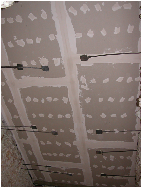
Rys. 2. Widok sufitu podwieszonoego od strony nagrzewanej przed badaniem
