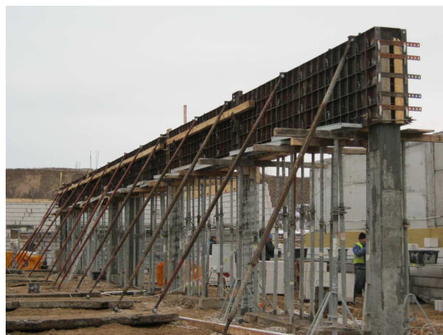
Fot. 17. System Raster wykorzystany do wykonania podciągów
