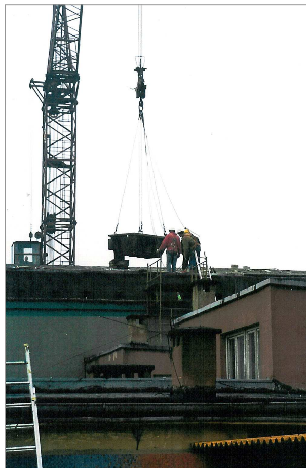
Rys. 5. Realizacja prac rozbiórkowych przy wykorzystaniu żurawia ŻB-75
