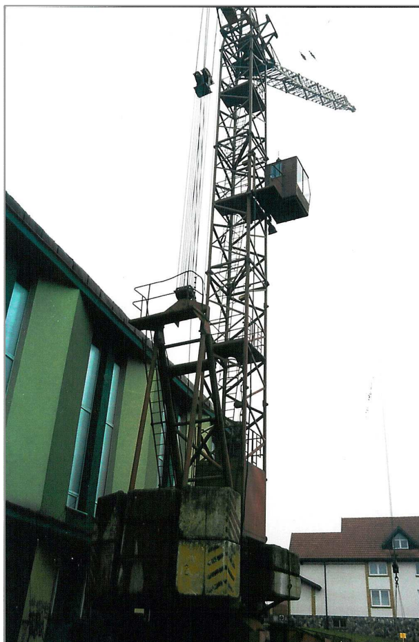
Rys. 5. Realizacja prac rozbiórkowych przy wykorzystaniu żurawia ŻB-75
