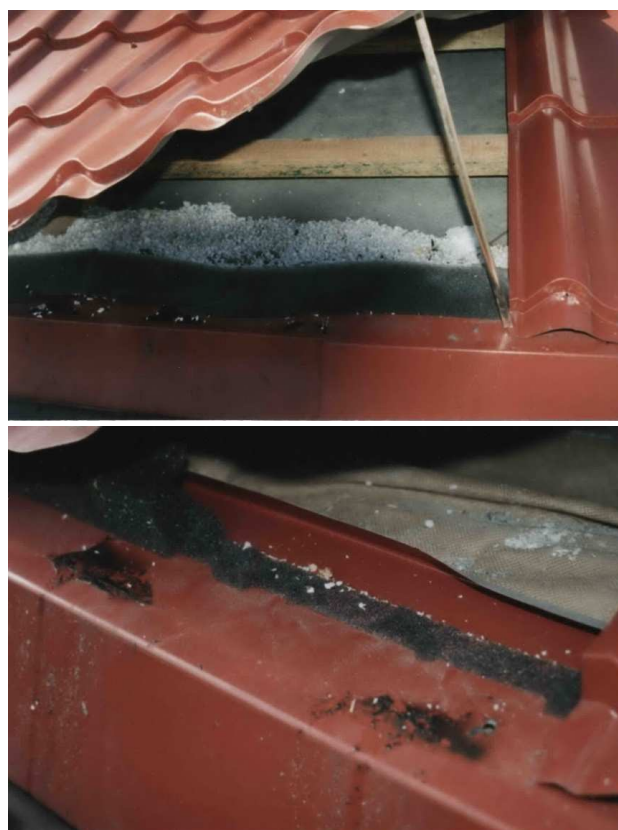
Rys. 2. Fragmenty okapu po częściowym demontażu pokrycia dachowego
