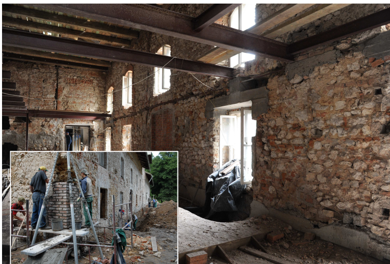
Rys. 1. Wady kwalifikujące do rozbiórki zabytkowy obiekt w stadium katastrofy
