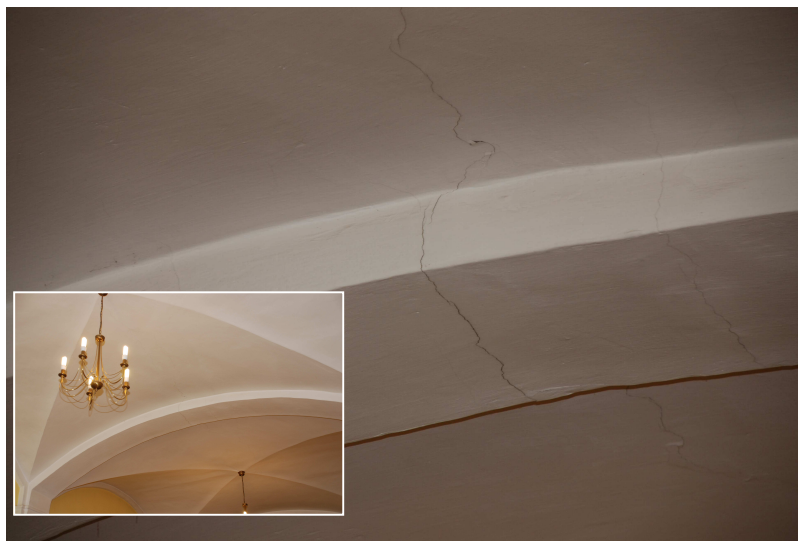
Rys. 4. Identyfikacja zarysowanych łuków i sklepień
