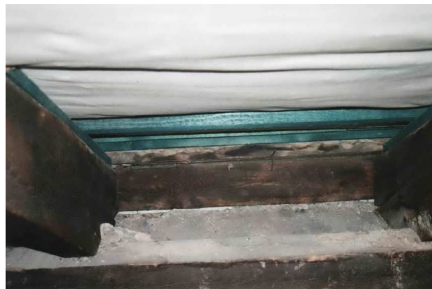
Rys. 4. Widok połaci dachowej z poddasza
