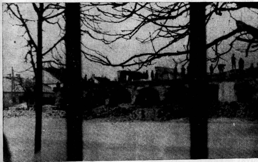
Rys. 4. Ruiny ratusza w trakcie rozbiórki
