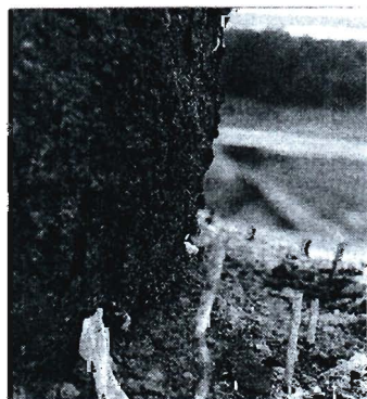
Rys. 7. Zewnętrzny fragment żelbetowej konstrukcji „latarni” i „dzwonu” zniszczony całkowicie bez możliwości napraw, pod wpływem wstępnego sprężenia metanu
