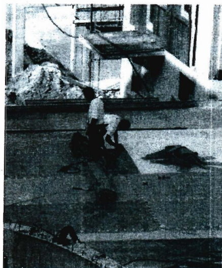
Rys. 2. Wibroizolacja pozioma całego budynku [7]
