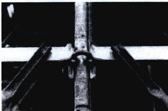
Rys. 3. Widok połączenia węzłowego rusztowania modularno-węzłowego. Fotografię wykonano na budowie auli Wydziału Elektrycznego Politechniki Białostockiej.
