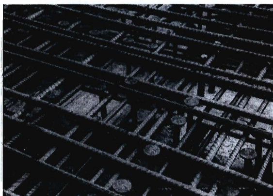
Rys. 6. Szczegóły realizacji węzła z wykorzystaniem listwy dyblowej
